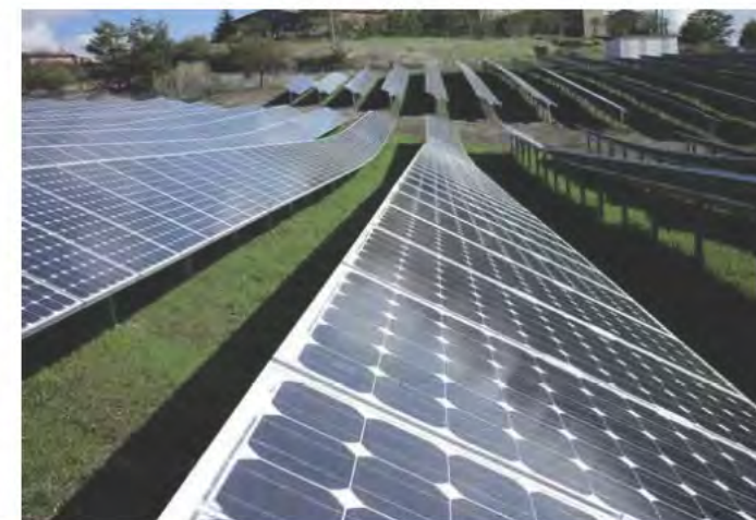
På græsningsarealet kan der måske på sigt opsættes solceller til energiproduktion
